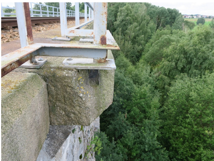
Foto č. 6 1. bezpečnostní výklenek vpravo - odpadlý roh římsy pod sloupkem zábradlí.
