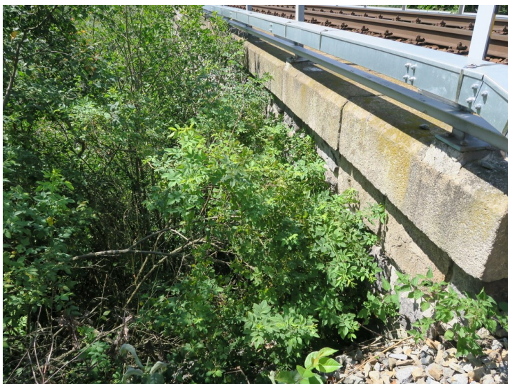
Foto č. 4 O 01 - křídlo vlevo - silně zarostlý svah u křídla.
