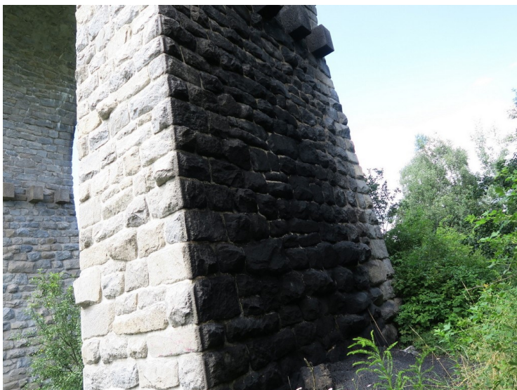
Foto č. 5 P 01 - směrem do 1. otvoru - opálení od ohně.
