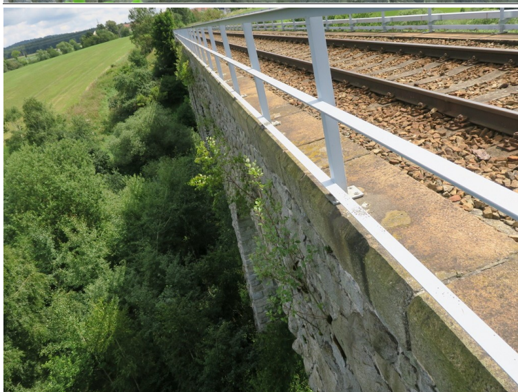
Foto č. 2 K 05 - K 07 - čelní zdivo vpravo - nárůst náletových dřeviny ve spárování.
