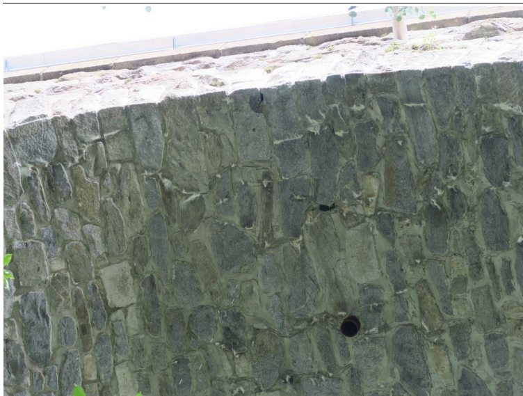
Foto č. 1 K 04 - vrchol klenby vlevo - průsaky s výluhy a vypadané spárování.
