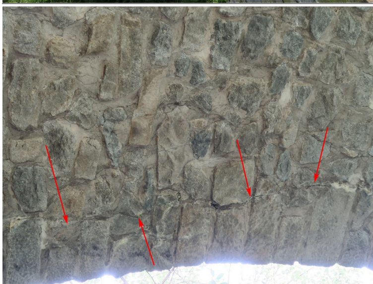
Foto č. 3 K 09 - vrchol, vpravo - podélní trhlina za věncem klenutí s průsaky.
